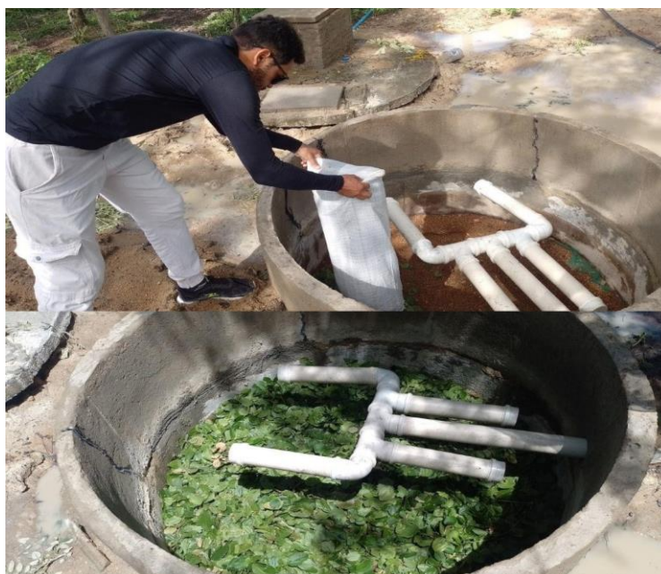
Figura 03. Detalhamento do filtro físico e suas respectivas camada
