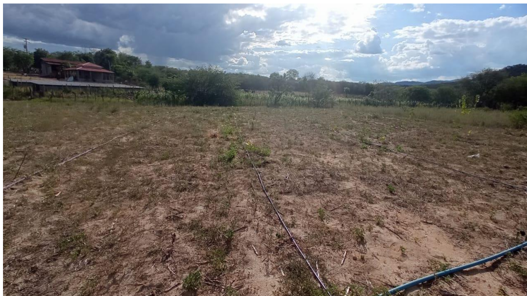
Figura 6. Sistema de irrigação por gotejamento instalado na área experimental.
